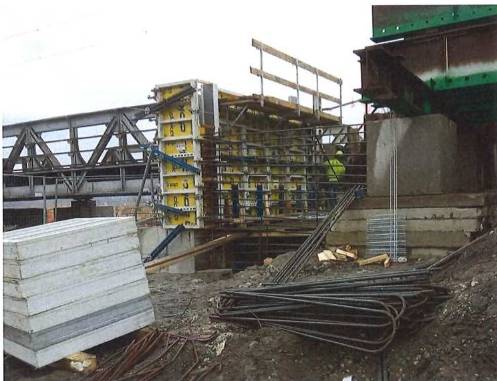
Debnenie záverného múrika na opore č.1 – SO 12-33-02
