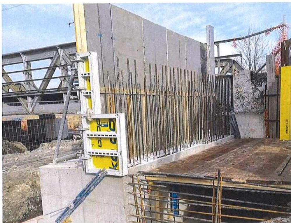
Armovanie a debnenie záverných múrikov opôr č.1 a č.3 – SO 12-33-02
