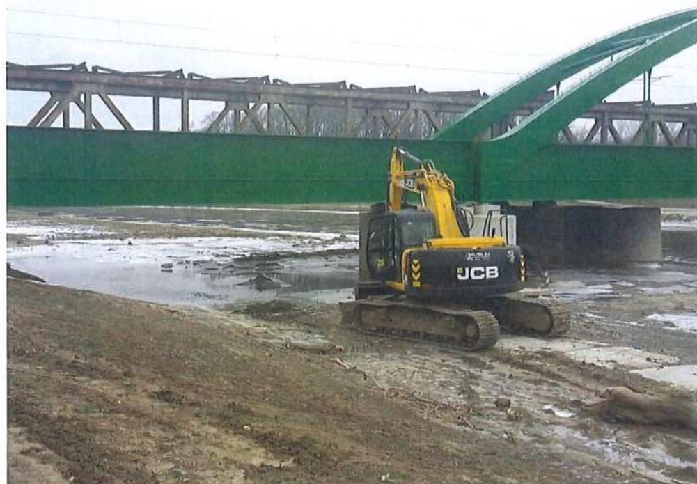
Výzisk materiálu pre prístupovú cestu cez SO 12-33-03
