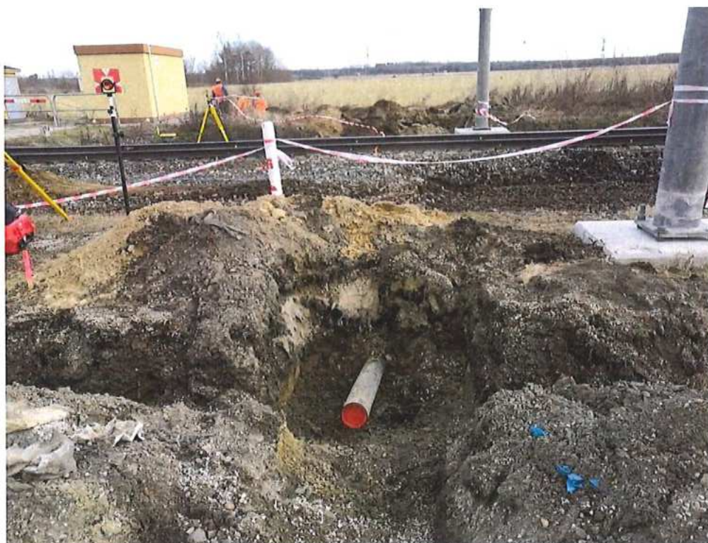
Realizácia pretlaku v km 71,700
