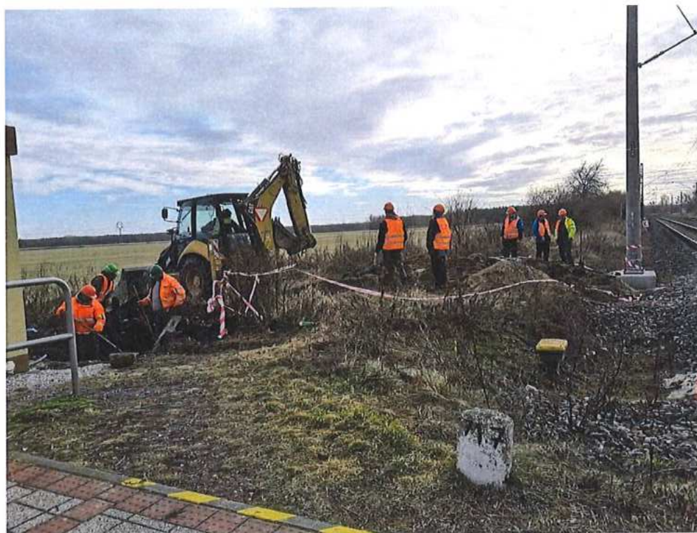
Prekládka optického kábla a MK – PS 11-22-02 a 03
