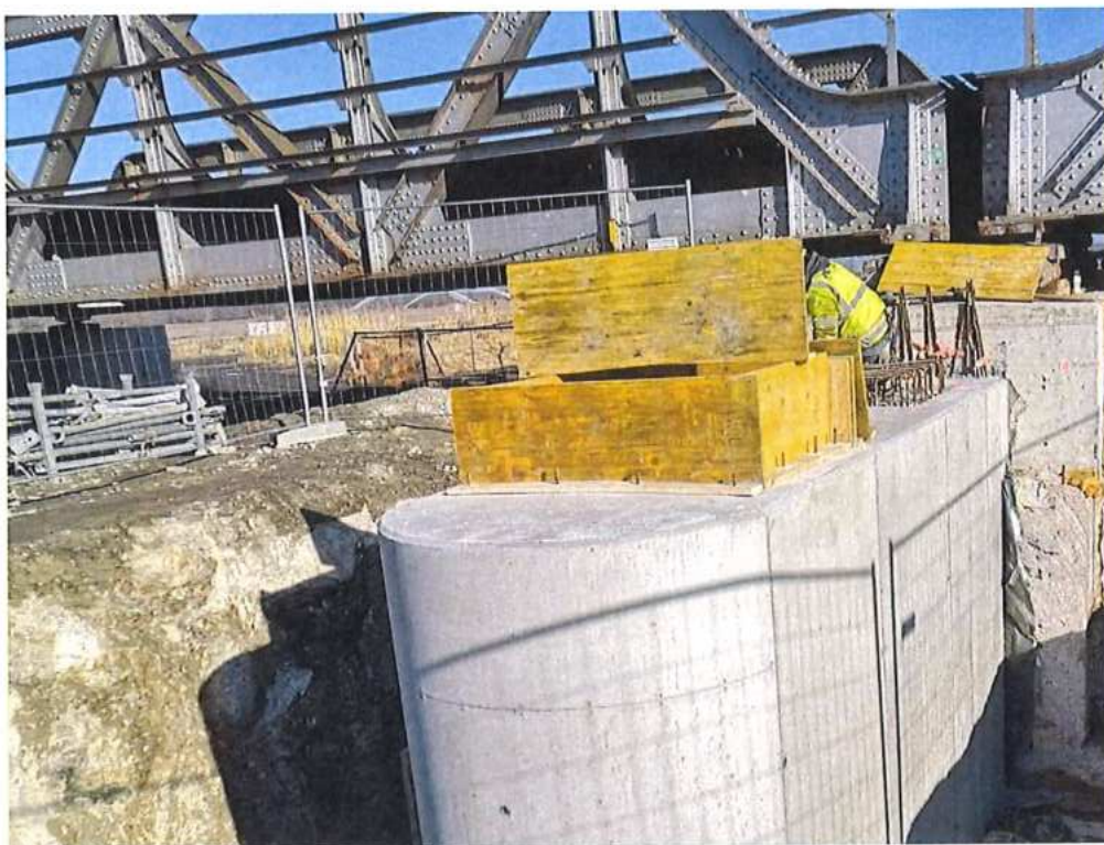
Debnenie podložiskových bločkov na pilieri č.2 – SO 12-33-02
