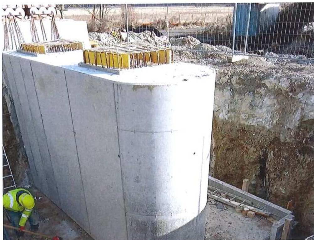
Oddebnenie drieku piliera č.2 – SO 12-33-02
