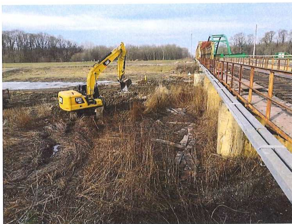
Príprava platformy pre demontáž predpolí – SO 12-33-04
