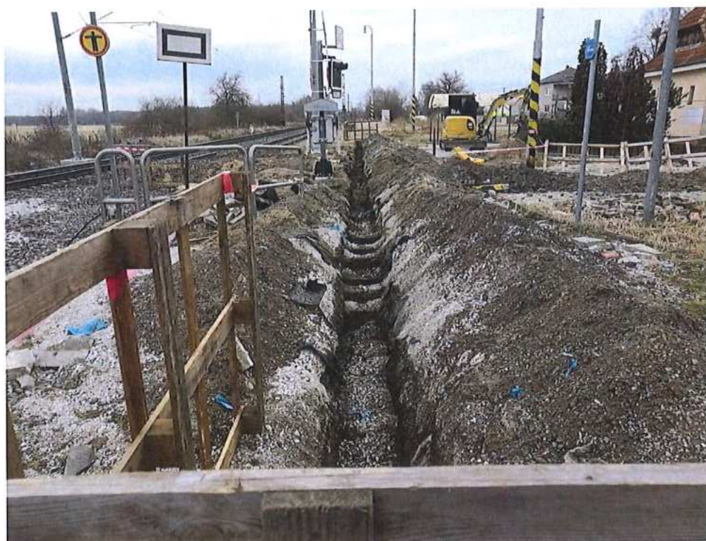
Výkopové práce pre prekládku optického kábla a MK – PS 11-22-02 a 03
